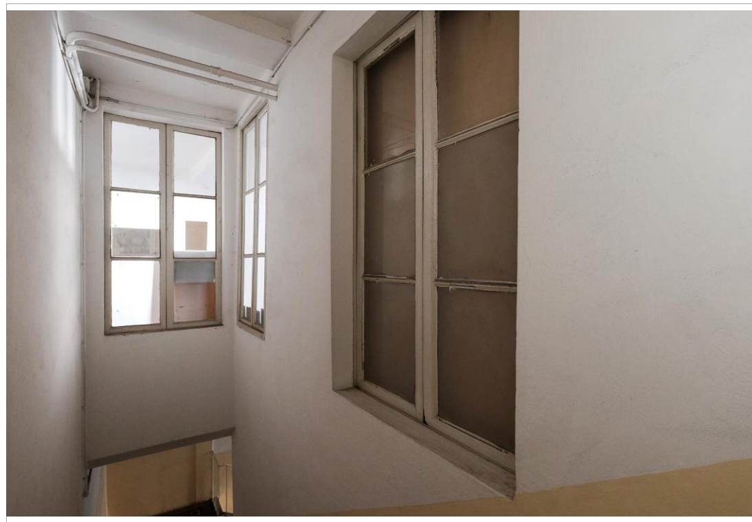
le finestre interne verso i locali della biblioteca
