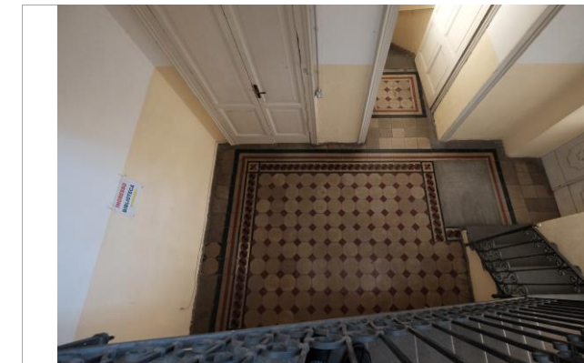
pavimentazione del vano scala
