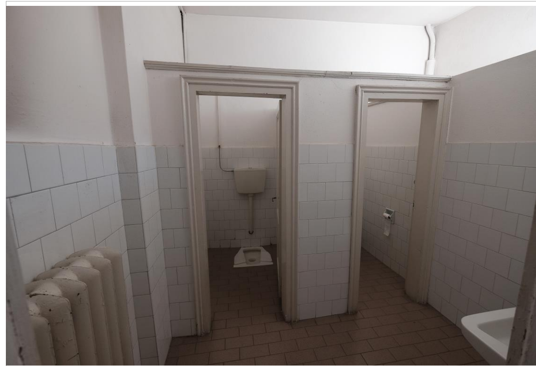
vista dei servizi igienici
