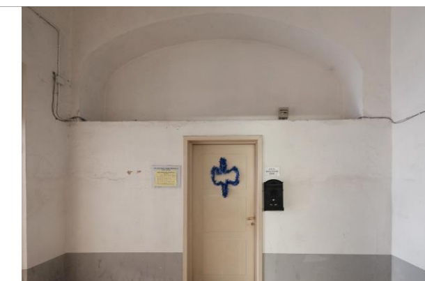
particolare della parete sud est
