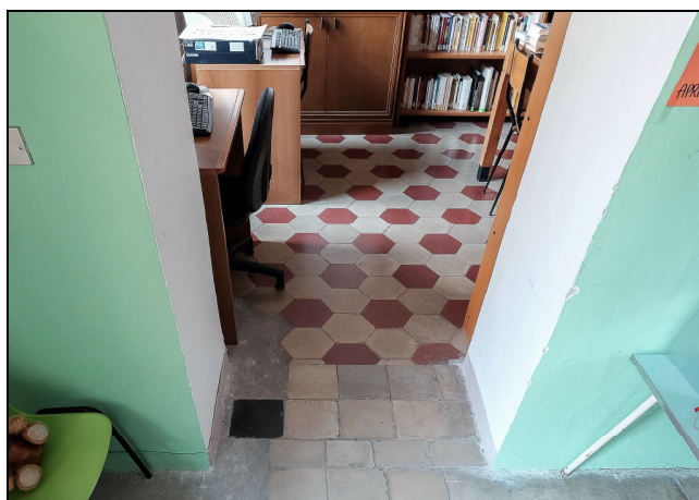
prese fotografiche pavimenti esistenti
