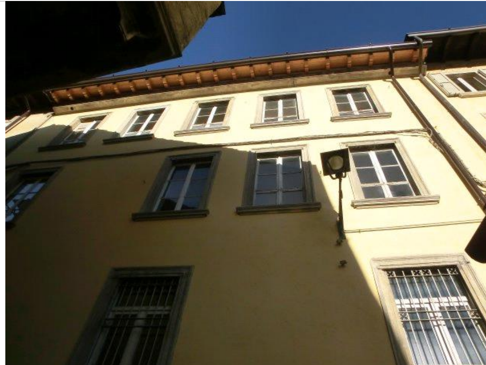
particolare facciata da via Valmezzera
