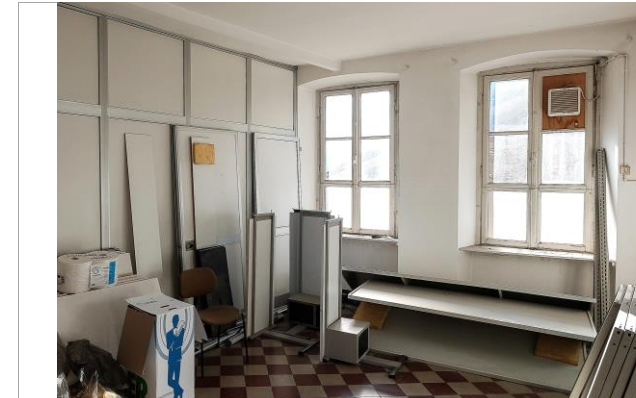
particolare serramenti esterni
