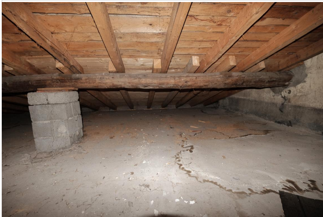
vista verso nord est
