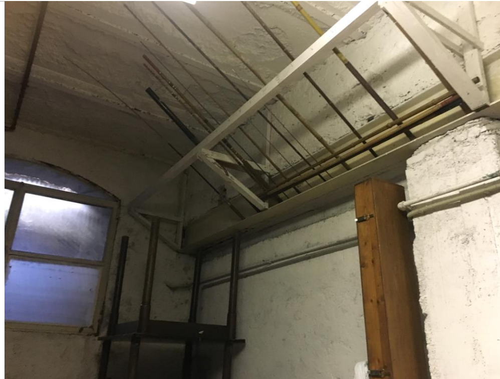
vista verso est
