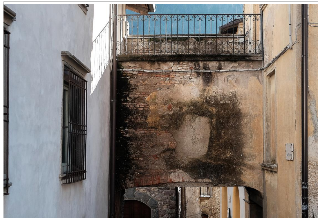
vista esterna lato verso monte
