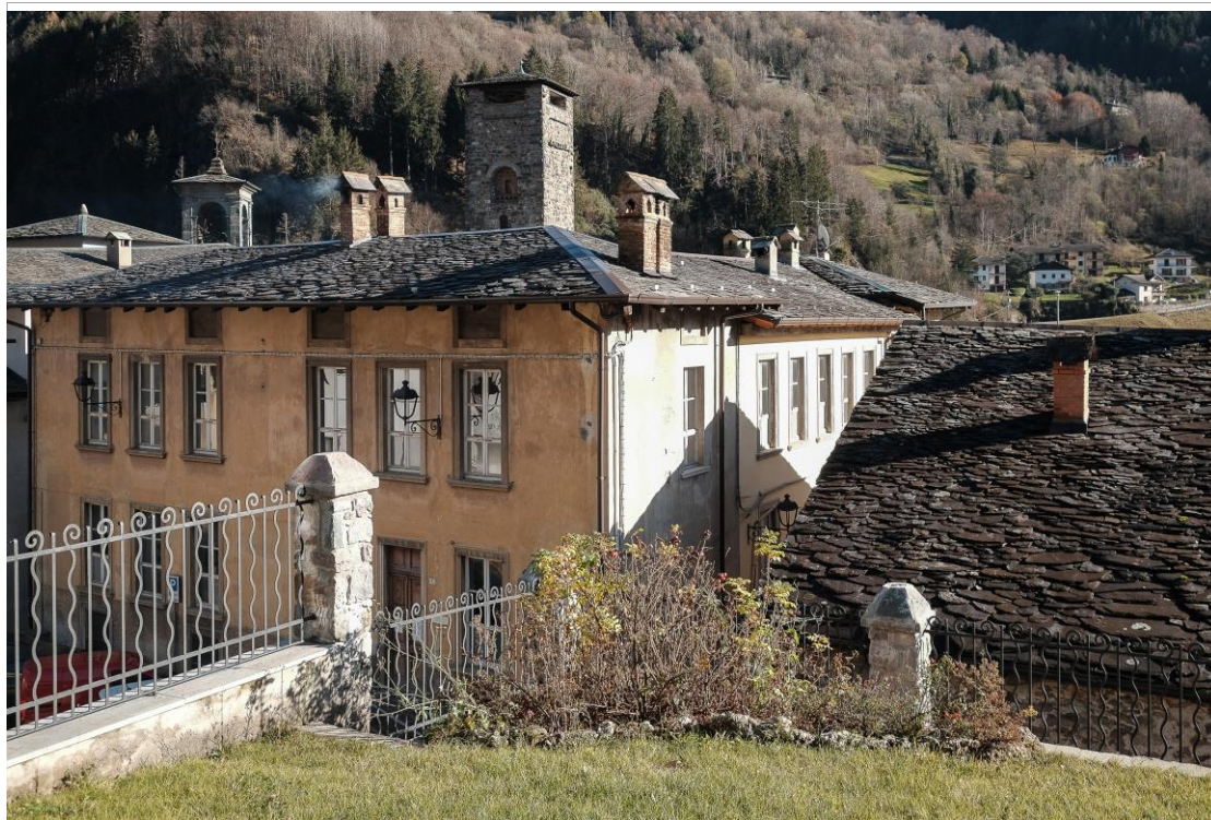
lo spigolo nord ovest del fabbricato
