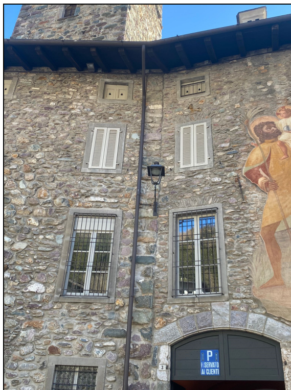
presa fotografica intervento effettuato sul castello Ginami
